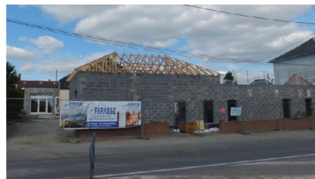
Désormais les travaux vont se poursuivre à l'intérieur, avec le doublage des murs, l'isolation et le cloisonnement des locaux, l'aménagement des espaces, la pose des menuiseries et des carrelages, l'installation des sanitaires et de la chaufferie, jusqu'aux toutes dernières finitions qui devraient intervenir début juillet, tel que c'était prévu au calendrier de ce double chantier.
